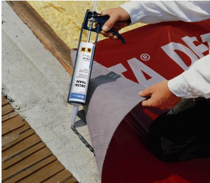
**Description:** colle pour les raccords aux murs. Pour le collage des recouvrements des feuilles DELTA® (sauf les membranes DELTA®-MAXX).
